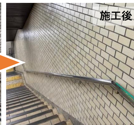
湊川公園駅 施工状況 (特別清掃)
