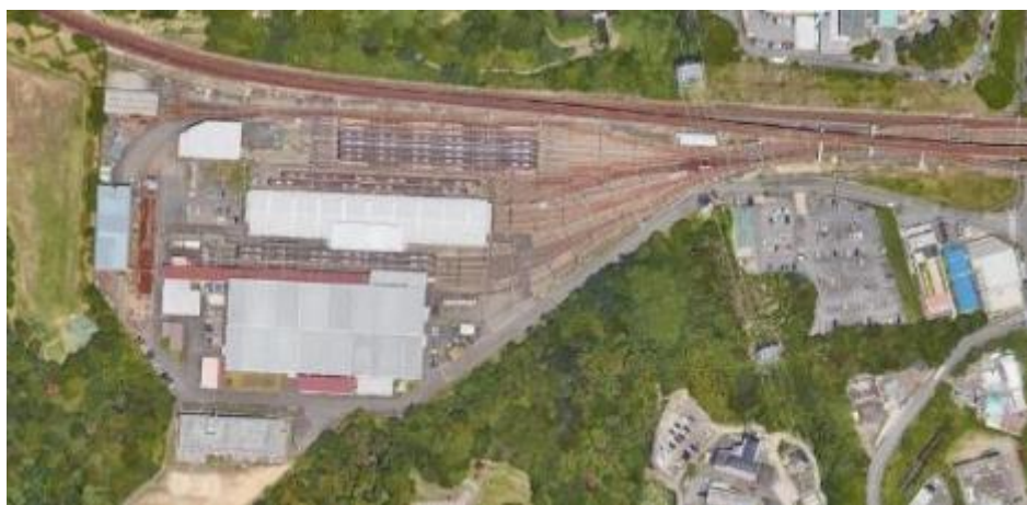
名谷車両基地（太陽光発電設置検討中）
