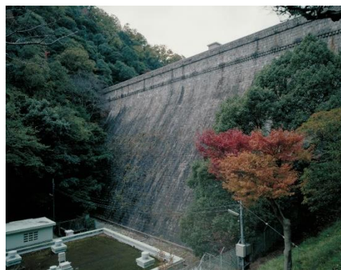
図 57 布引水源地水道施設（五本松堰堤）
