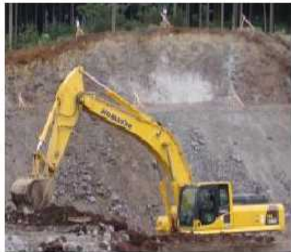
屋外での作業、一品生産
