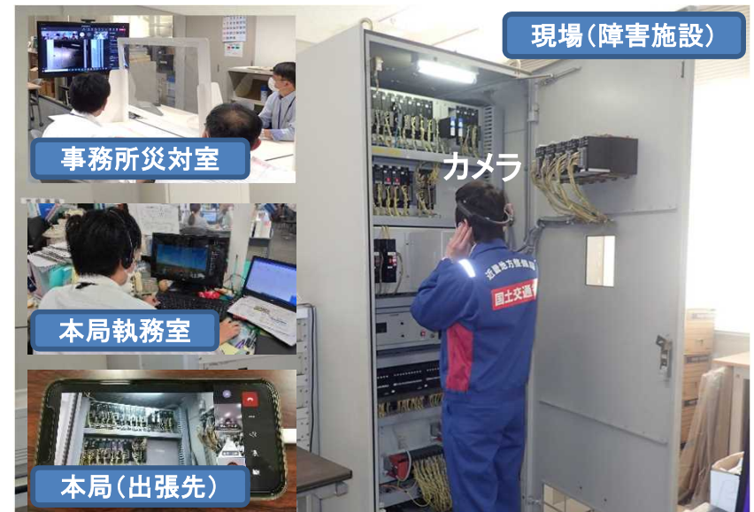
ポンプ停止事故現場で復旧支援(R4.11.11紀の川)
