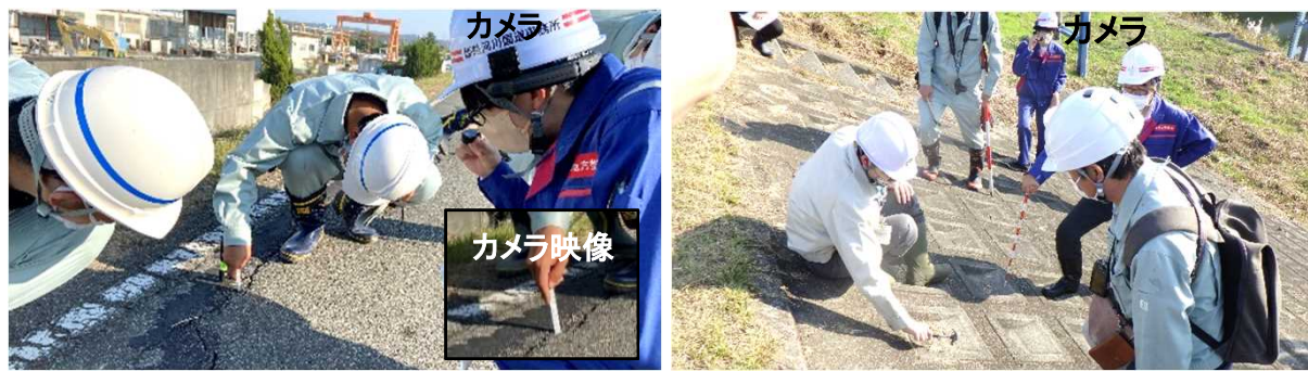
堤防点検研修会におけるWEB参加向けの情報共有(R4.11.11加古川)
